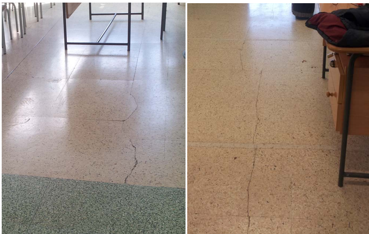
Foto 1 e 2 – Parti di pavimentazione da sostituire
