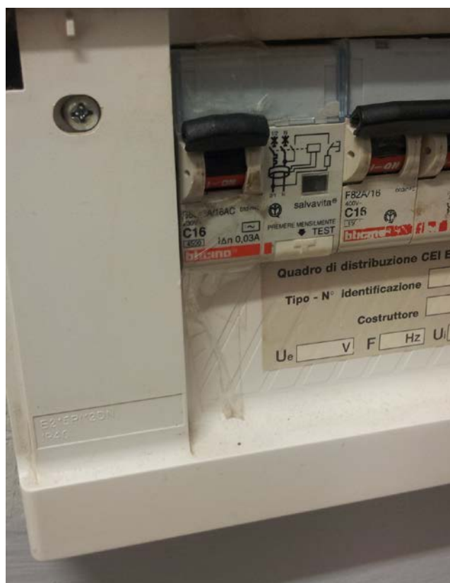
Foto 5 – Particolare cassetta incasso quadro elettrico
